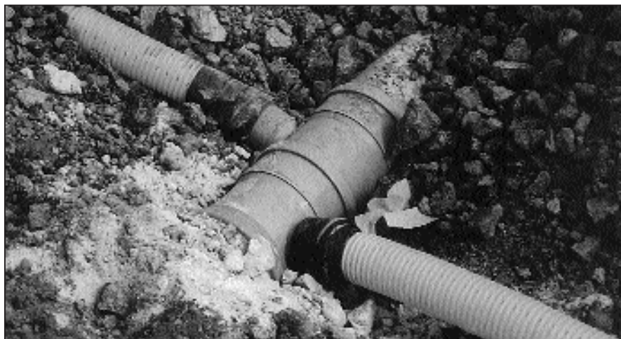
Abb. 3: Vom Revisionschacht aus verläuft eine abgedichtete KG-Rohrleitung mit eingebauten Abzweigformteilen. Die KG-Rohrleitung baut den Kompressordruck mit vier bar auf und verteilt ihn über die Abzweige in die Saugerdrainagen.
