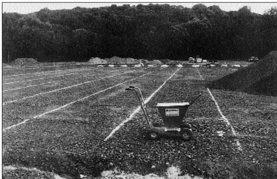
Abb. 2: Das Spielfeld wird nach den ermittelten Abstandswerten abgekreidet, damit die Leitungsstränge exakt ausgefräst werden können.
